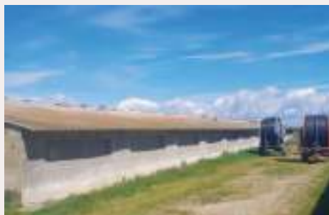
Guillaume Delay dispose de deux anciens bâtiments d'élevage qui contiennent de l'amiante.
